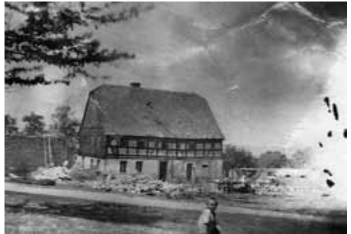
Auf dem Foto ist das Geburts- und Wohnhaus mit einem besonders schönem Fachwerk mit (Eckverstrebung Halber Mann) und herumliegenden Bauschutt zu sehen.
