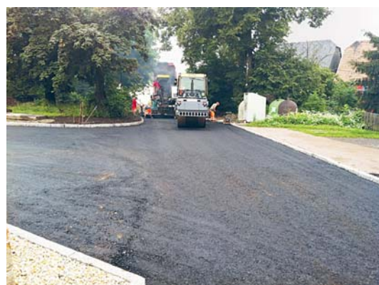
Bitumeneinbau Zufahrt zur Feuerwehr Wiesenburg.
