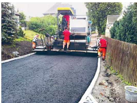
Bitumeneinbau im Bereich Lindenstraße 14 und 15.
