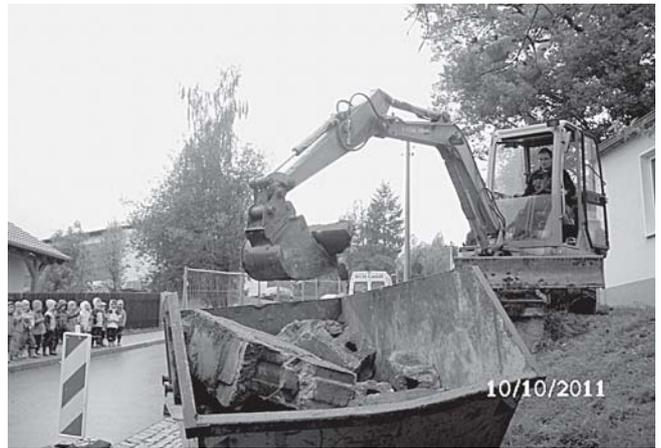
Mit viel Lärm wurde die alte Mauer weggerissen, alles ausgeschachtet, neu verfüllt und dann eine neue Mauer aus riesigen L-Steinen gebaut. Danach verlegten die Bauarbeiter neues Pflaster und auch ein neuer Zaun wurde errichtet. Dadurch entstand viel, viel mehr Platz für uns zum Spielen. Bis bald mal wieder - eure „Dachse“ von den „Happy Kids“.
